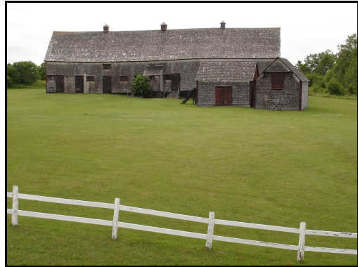
Parcelle #8 (bâtiment agricole a)
