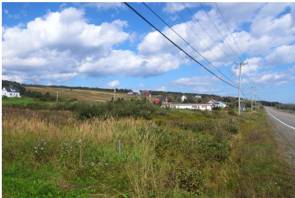
08 septembre 2011 13:25 - Photographie : ObsLabAgfRP-SitPsg5-a-20110908-R1110229.JPG
