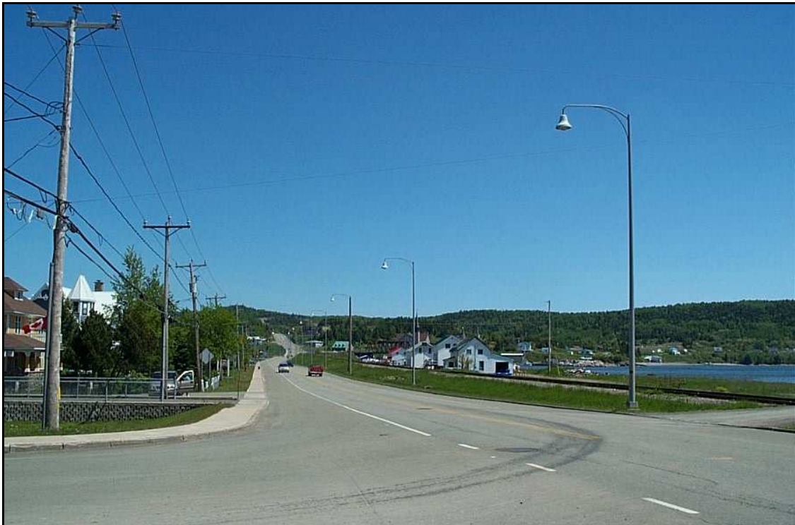
Photo 1 : Route 132 à Port-Daniel-Gascons (secteur Port-Daniel)
